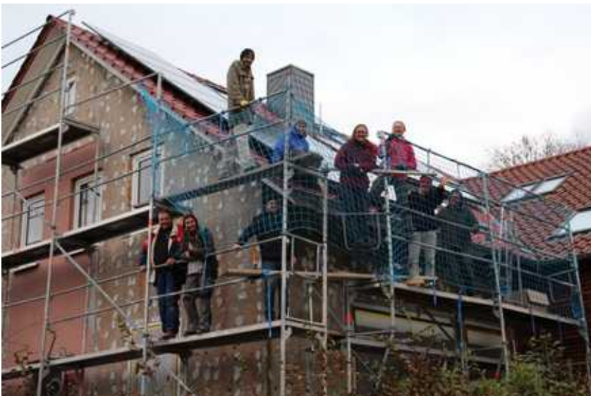
Selbstbaustelle mit vielen Helfer*innen
